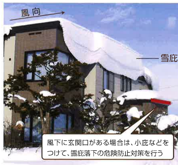
■写真:9 建物の風下側に発生した雪庇
